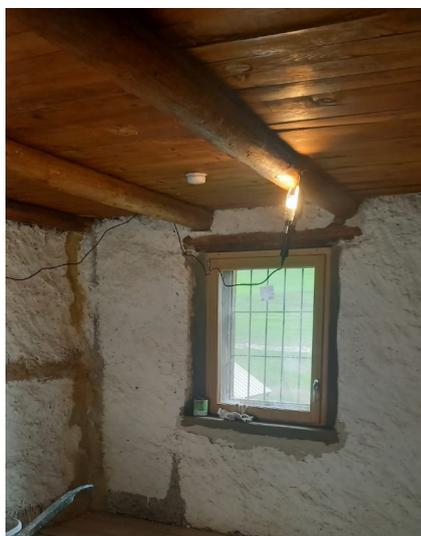
Une autre priorité est l'aménagement de ce petit dortoir. Nous avons démonté les structures lits que nous avons soigneusement rangés dans l'atelier. La fenêtre a été changée. Le réaménagement futur consiste à isoler la sous-toiture, la pose de lambris, le blanchiment des murs, le remontage des lits,...
